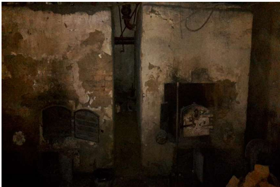
Котельная № 10 – внутренний осмотр
