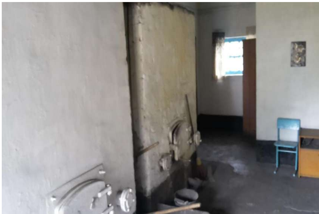
Котельная № 9-внутренний осмотр
