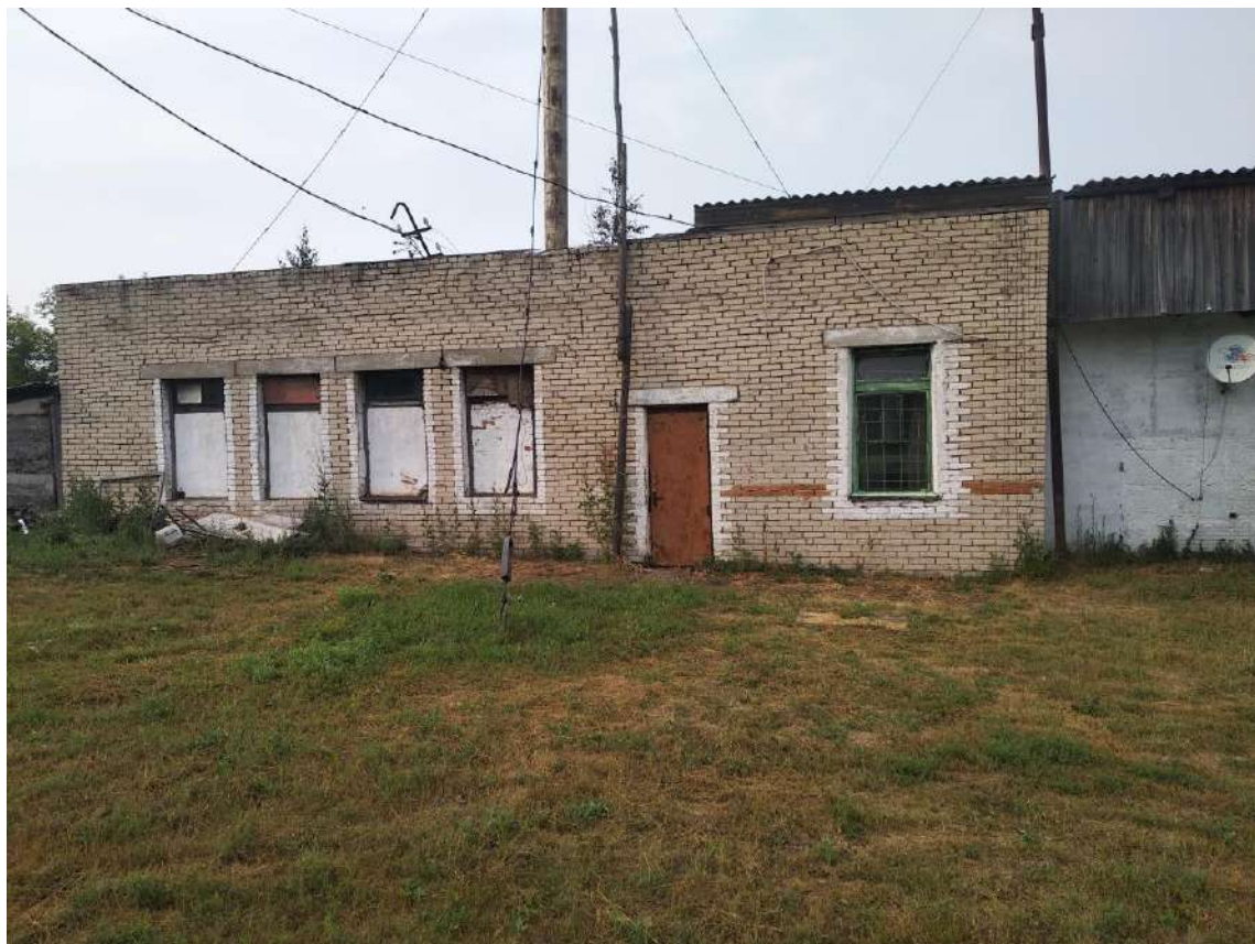
Котельная № 3 - вид снаружи
