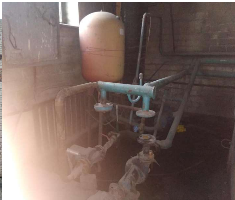
Котельная № 8 – внутренний осмотр
