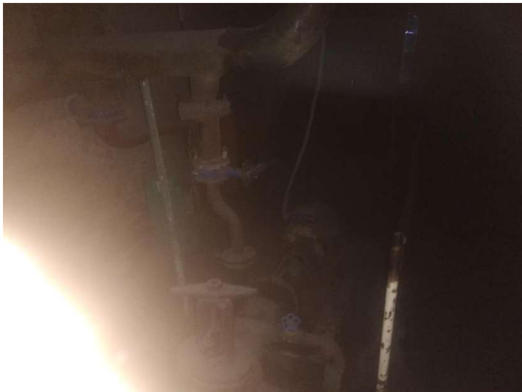
Котельная № 1-внутренний осмотр
