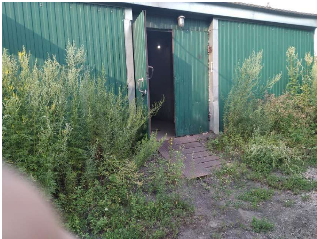
Котельная №13- вид снаружи
