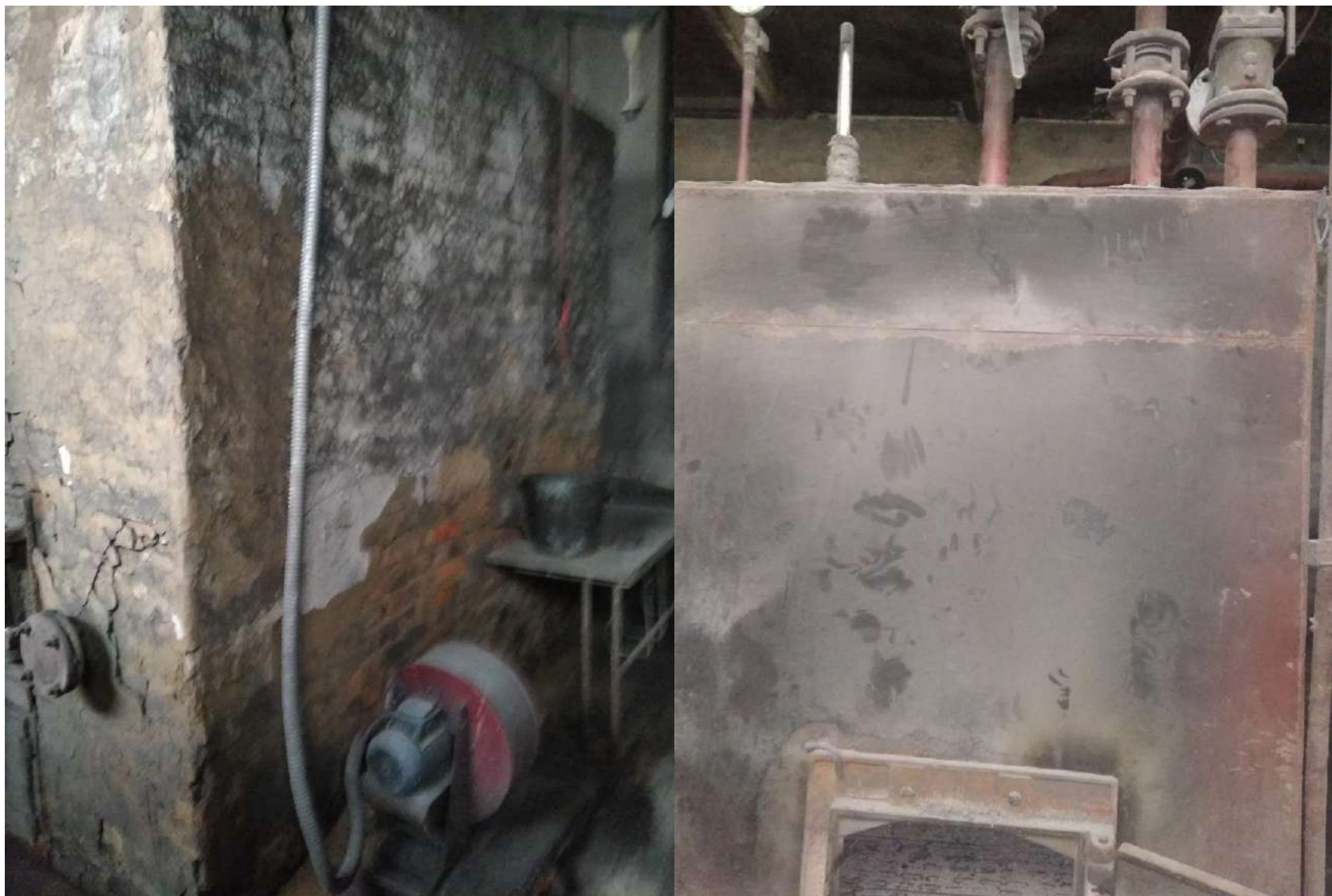
Котельная №16-внутренний осмотр
