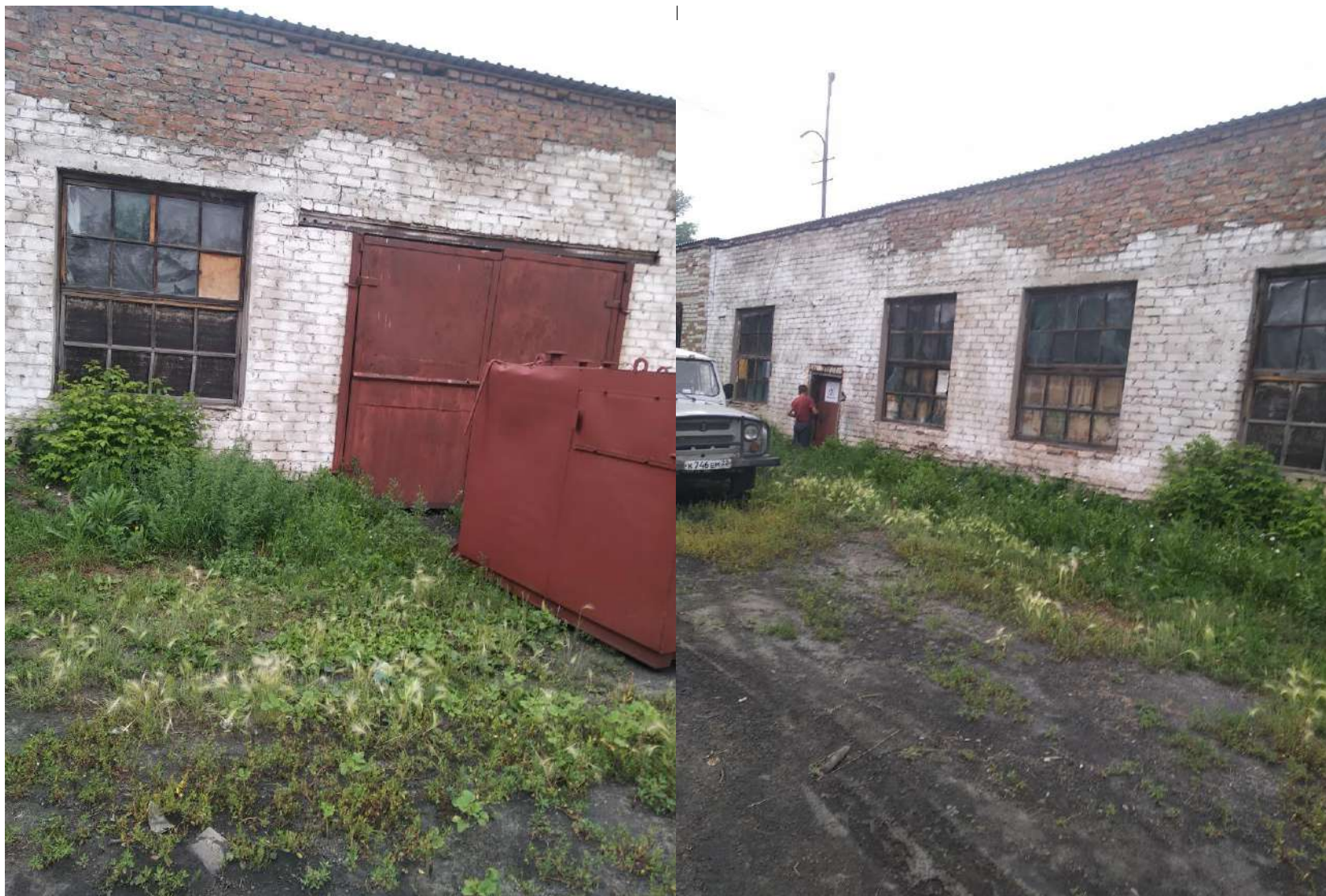
Котельная № 16- вид снаружи
