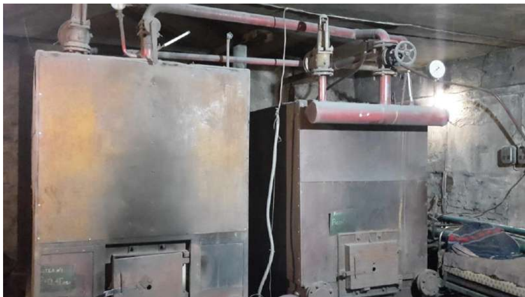
Котельная № 17 – внутренний осмотр
