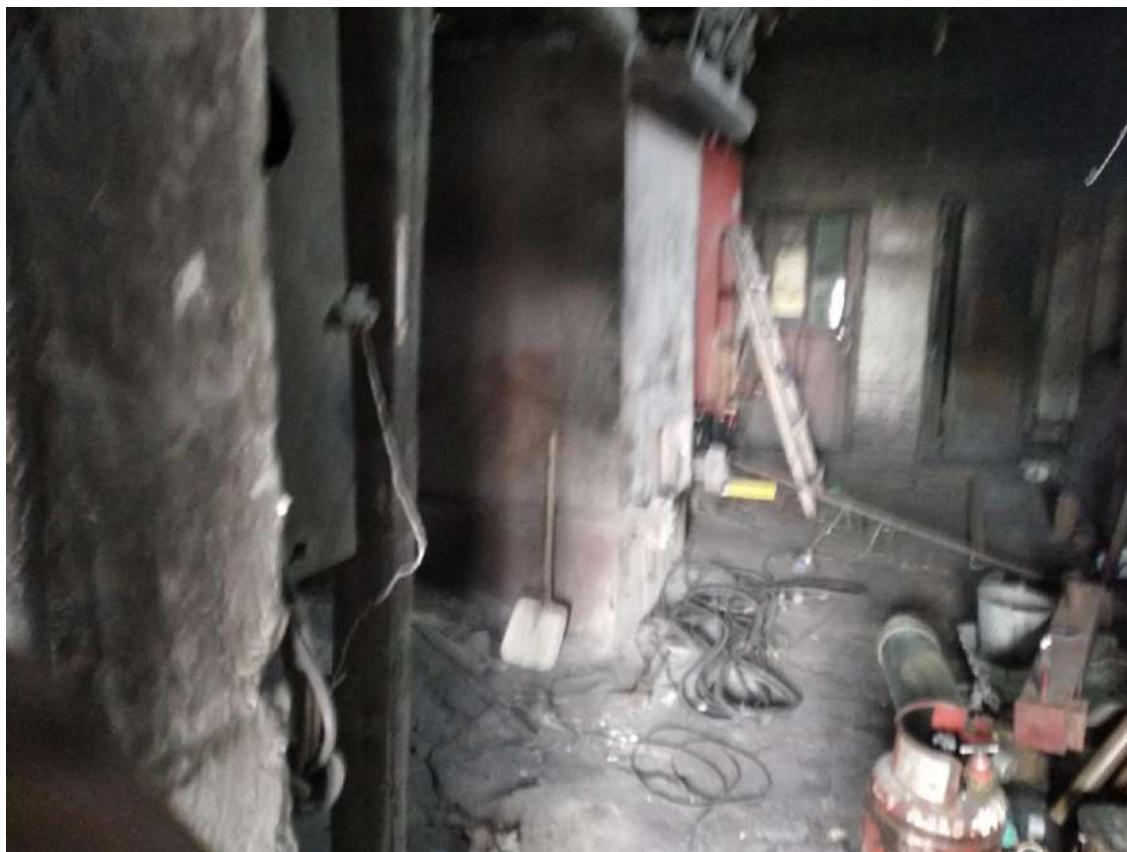
Котельная № 3 – внутренний осмотр
