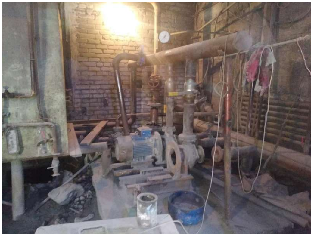
Котельная №7- внутренний осмотр
