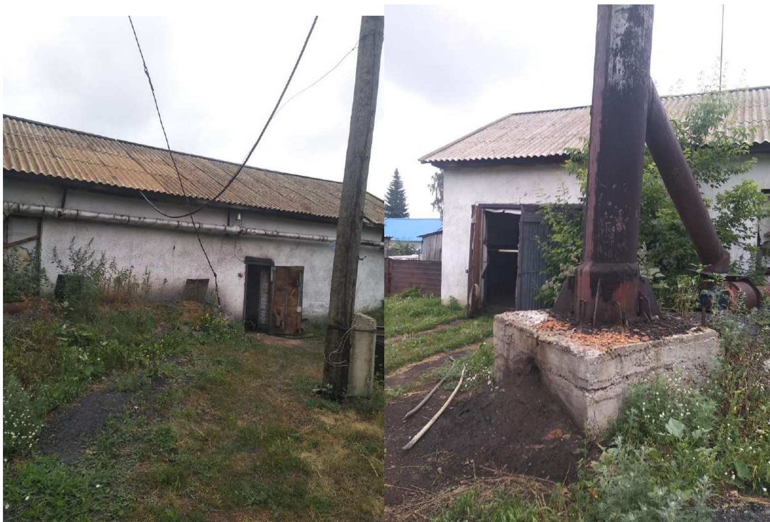
Котельная № 12 – вид снаружи
