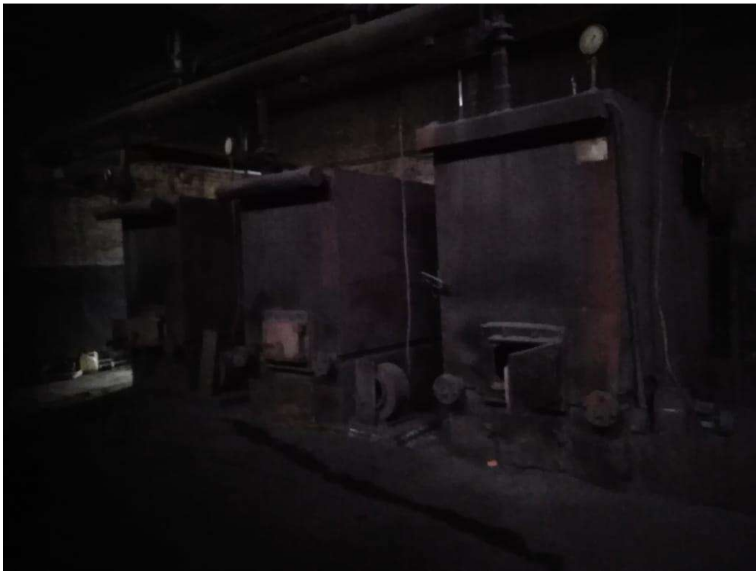
Котельная № 11 – внутренний осмотр
