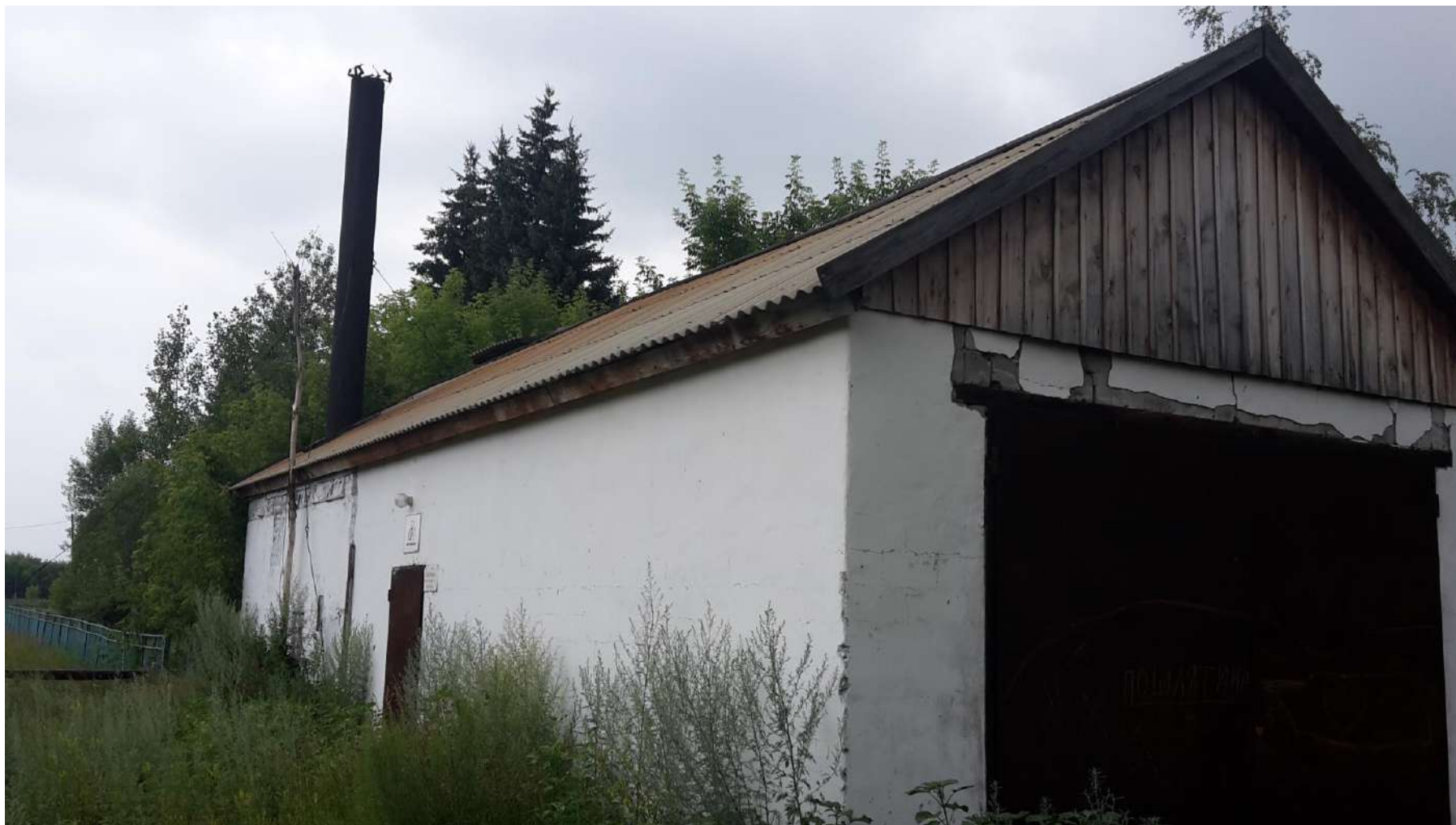
Котельная № 17 – вид снаружи
