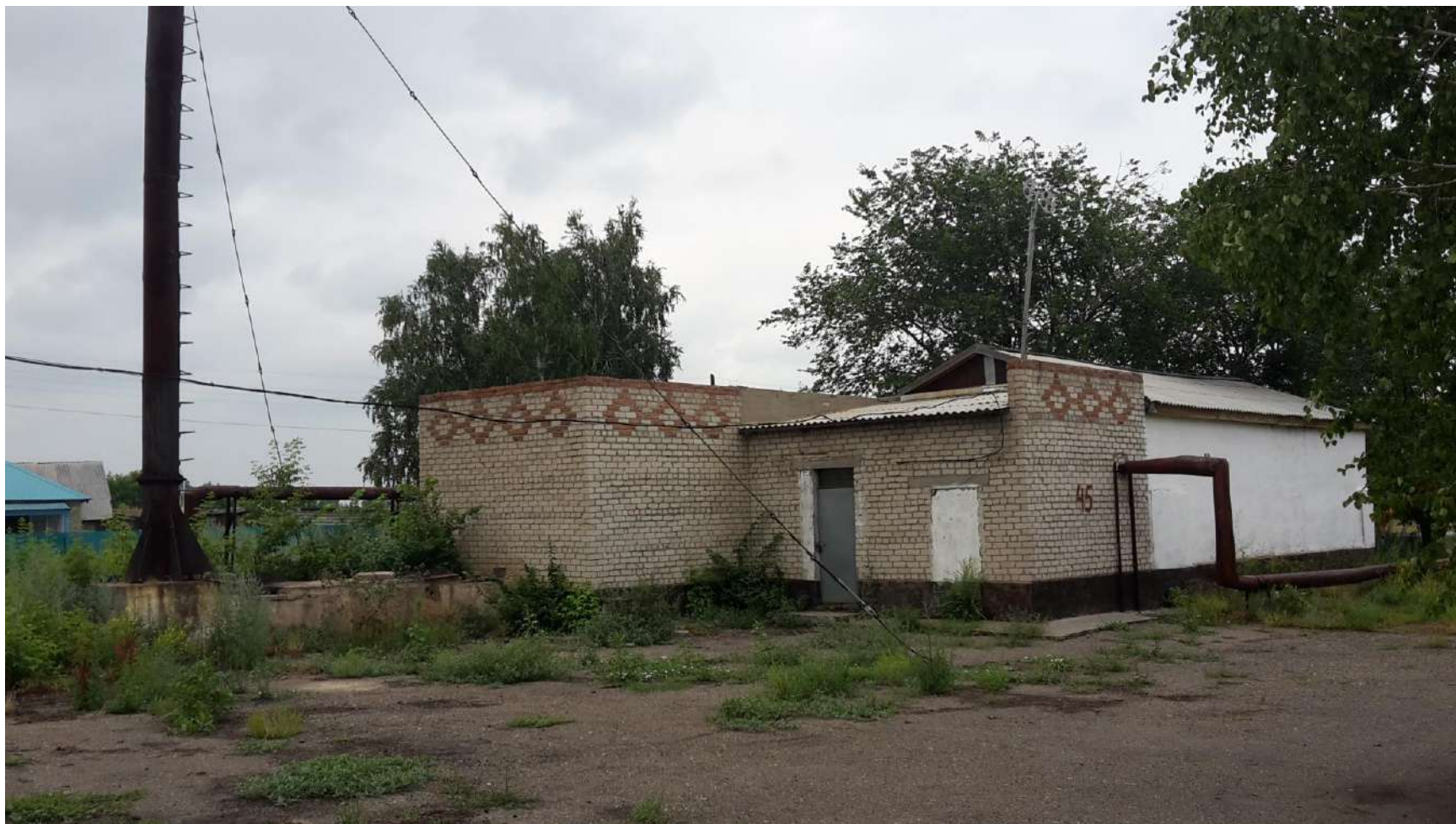
Котельная № 18- вид снаружи
