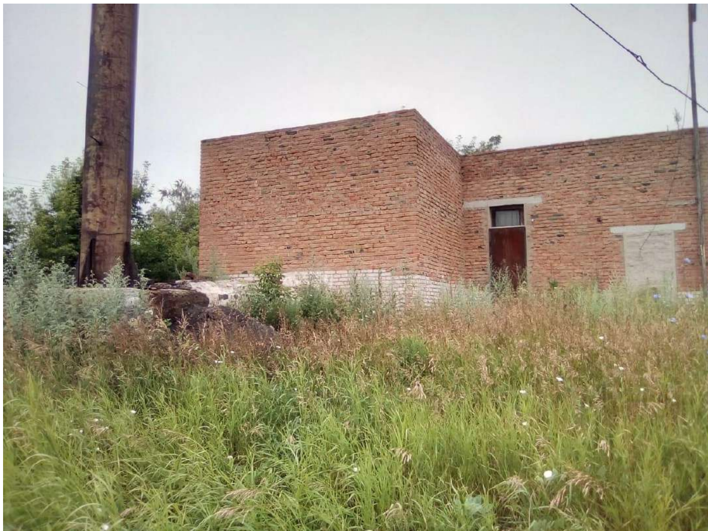
Котельная № 15 – вид снаружи
