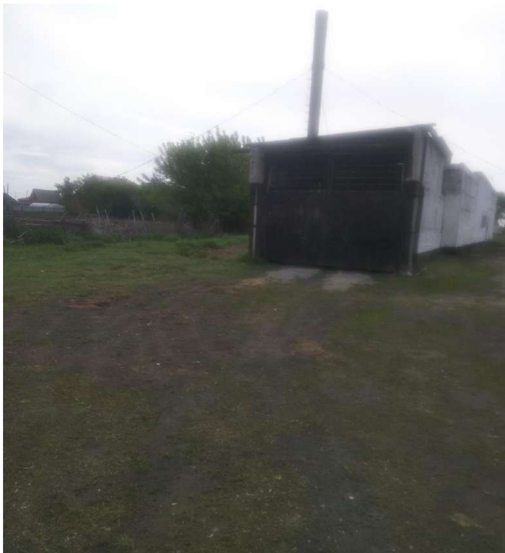
Котельная № 2 – вид снаружи
