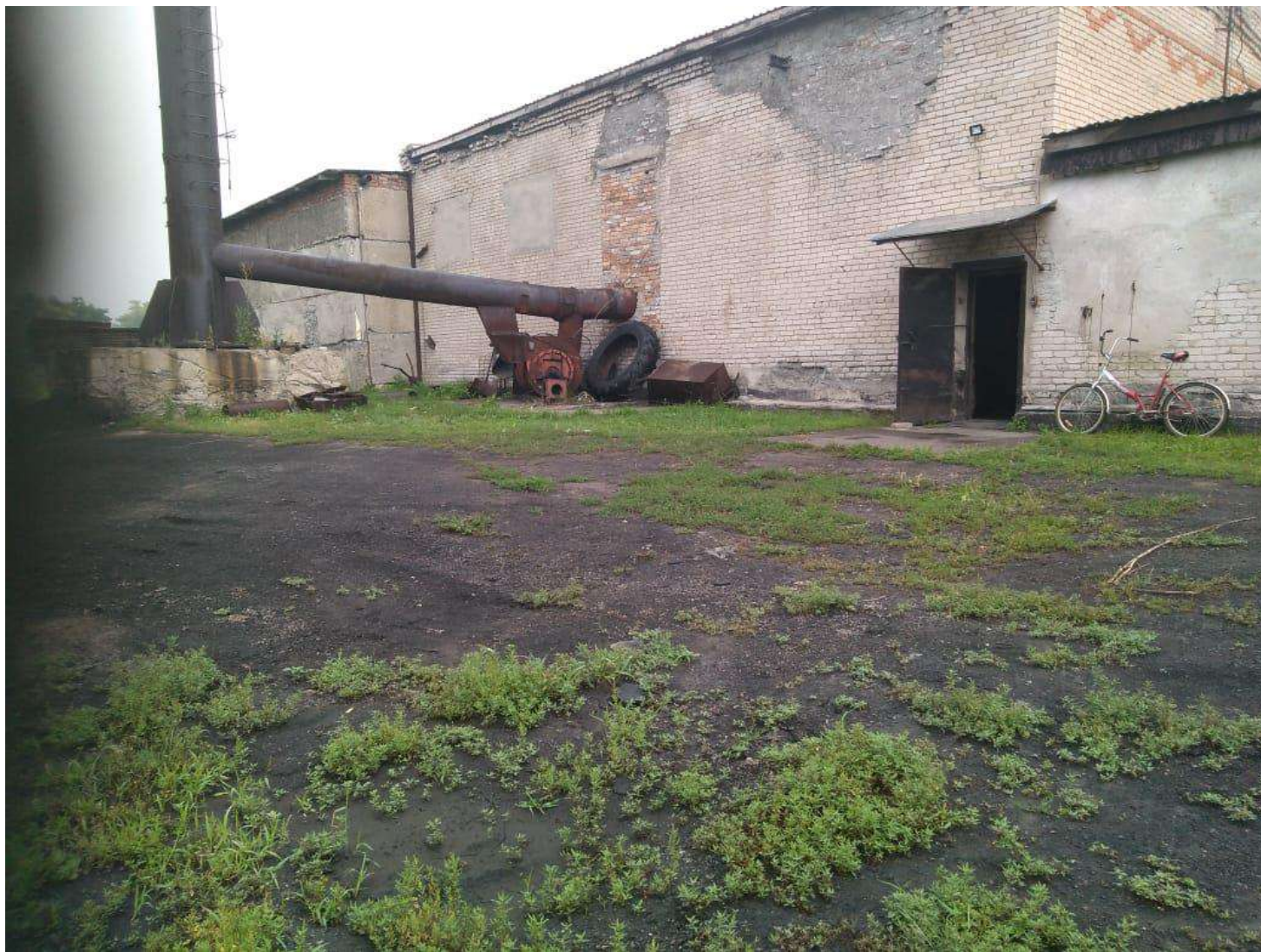
Котельная № 11- вид снаружи
