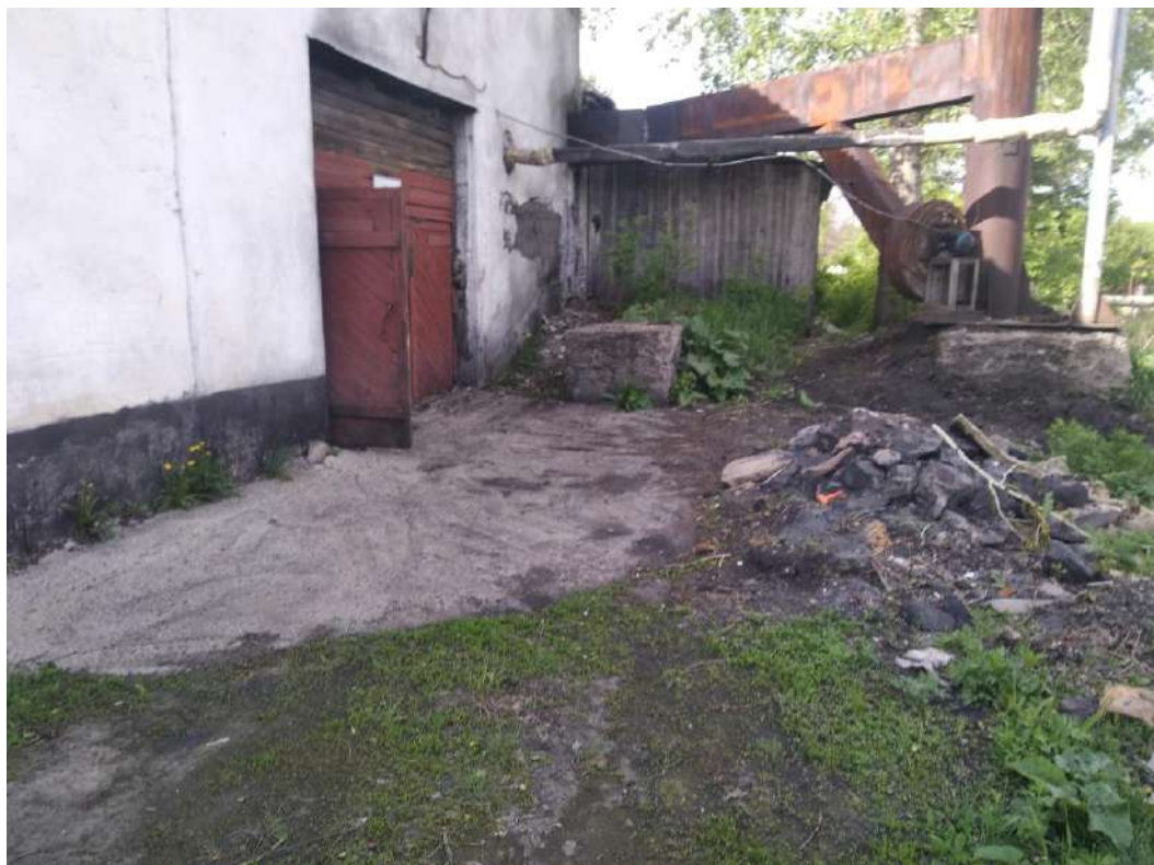
Котельная № 7 - вид снаружи
