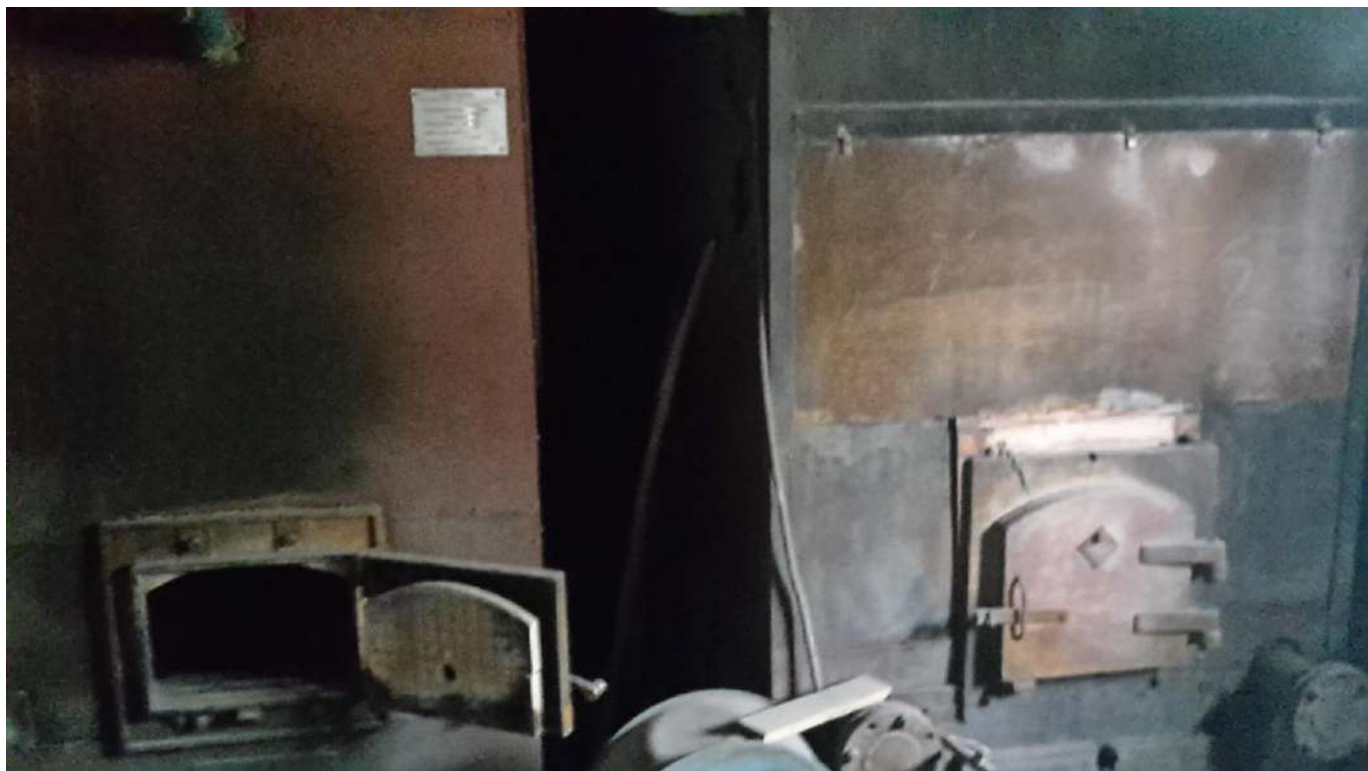
Котельная № 18- внутренний осмотр
