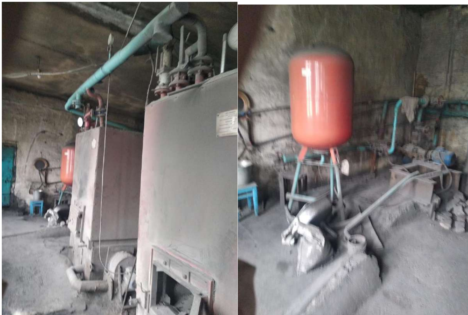
Котельная №14- внутренний осмотр
