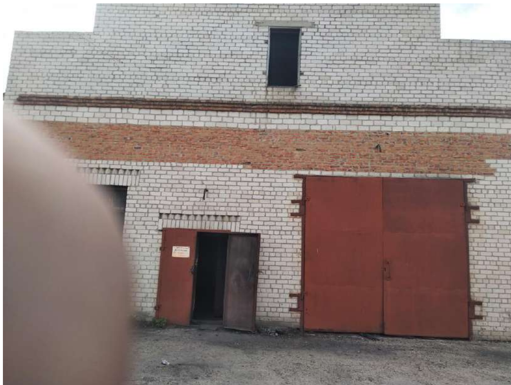
Котельная № 8 – вид снаружи
