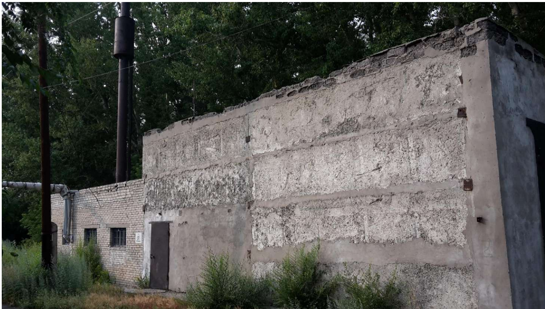
Котельная № 10- вид снаружи
