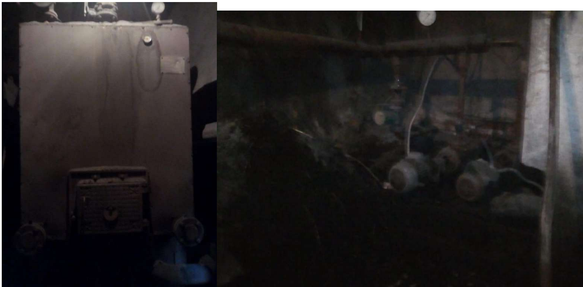
Котельная № 15- внутренний осмотр
